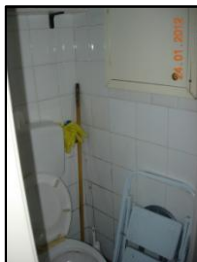
Vista locale W.C.
